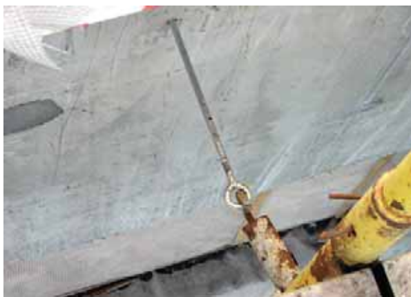
Монтаж строительных лесов
